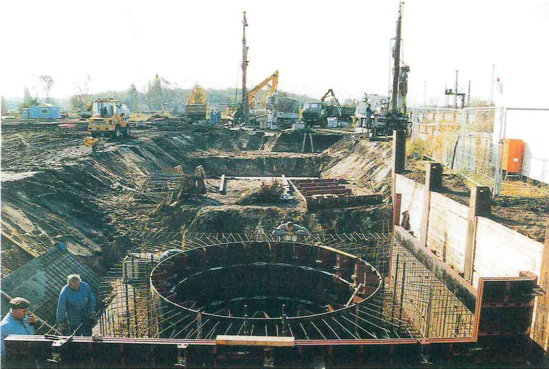
**Abb. 1:** Baugrundaushub und Herstellung der Belastungsfundamente
