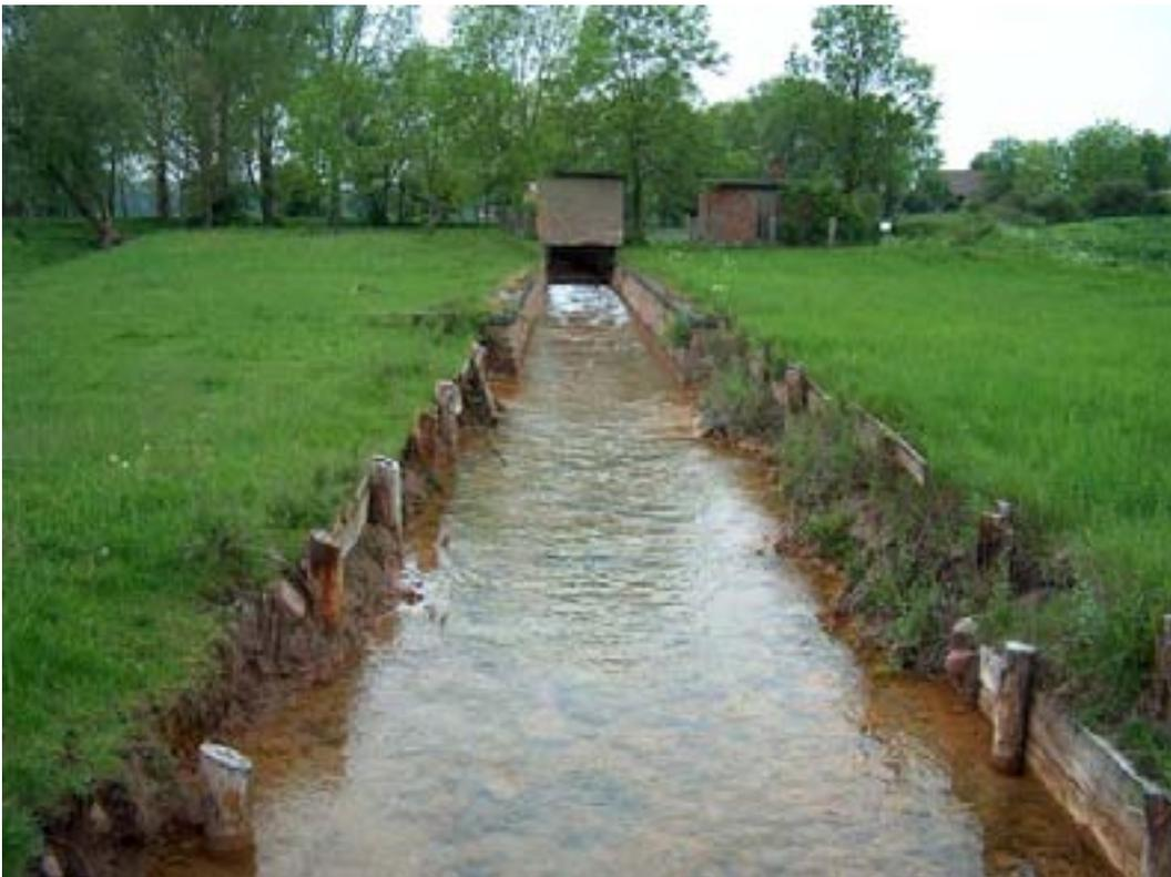
**Abb. 64** Mundloch des Schlüsselstollens. Auffällig sind hier die gelben bis braunen Ockerbildungen auf den Bachsedimenten. Dabei handelt es sich um Mineralkrusten aus Eisenhydroxiden ("Sinter"), die sich bei Sauerstoffzutritt aus dem Stollenwasser als feinkristalline Überzüge abscheiden. Diese Eisenhydroxide enthalten nach SCHRECK (2002) große Mengen Schwermetalle (besonders Pb) sowie Arsen und Phosphat.
