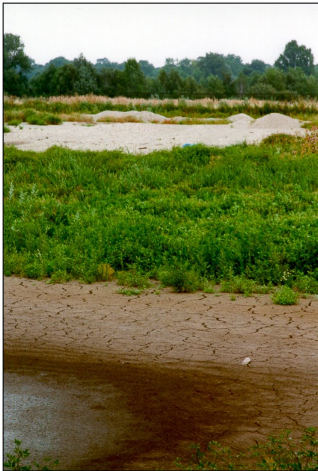
Abb. 5: Sedimentablagerungen in einem Absetzbecken der Geschiebefalle Kleindalzig, 20 km südlich von Leipzig, im August 1999 neun Monate nach der Befüllung mit Material aus der Weißen Elster - teilentwässert und von spontan entwickelter Vegetation bedeckt
