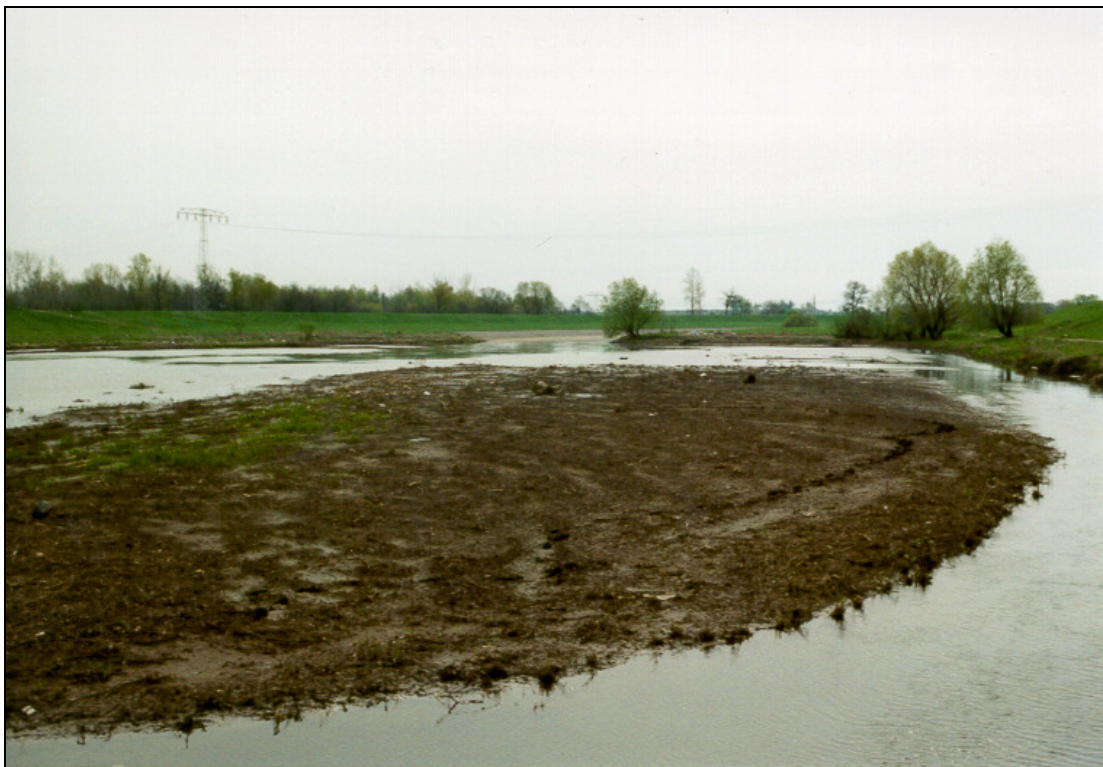
Abb. 4: Sedimentablagerungen der Weißen Elster in der Geschiebefalle Kleindalzig 20 km südlich von Leipzig im April 1998
