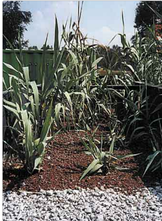
In einem Horizontalbecken von Xochitla sind auf vulkanischem Substrat Rohrkolben ( Typha latifolia ) angepflanzt worden. (Quelle: Umweltschutz Nord GmbH)
