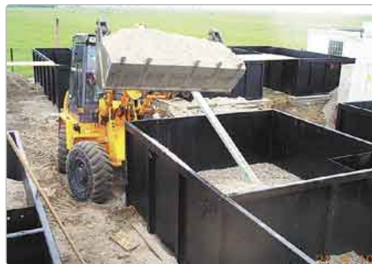
Jedes der 16 Klärbecken von Langenreichenbach ist mit etwa vier Kubikmeter Sand beziehungsweise Blähton gefüllt. In dem Substrat wurzeln die Pflanzen der Anlage, zugleich wirkt es als Filter. (Quelle: Dr. Roland A. Müller, UFZ)
