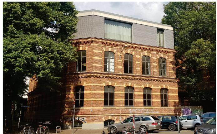
Abbildung 12 Kontorhaus in Leipzig - Geschossaufstockung Holz-Leichtbau (Foto von Nora Mittelstädt 2022)
