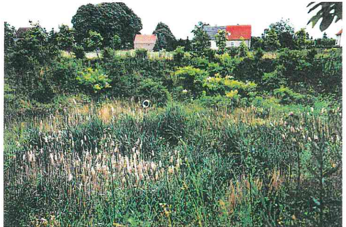
Foto 16: Regenwasserrückhalteanlage Gewerbegebiet Zorbau-Süd (ZOR01B)
