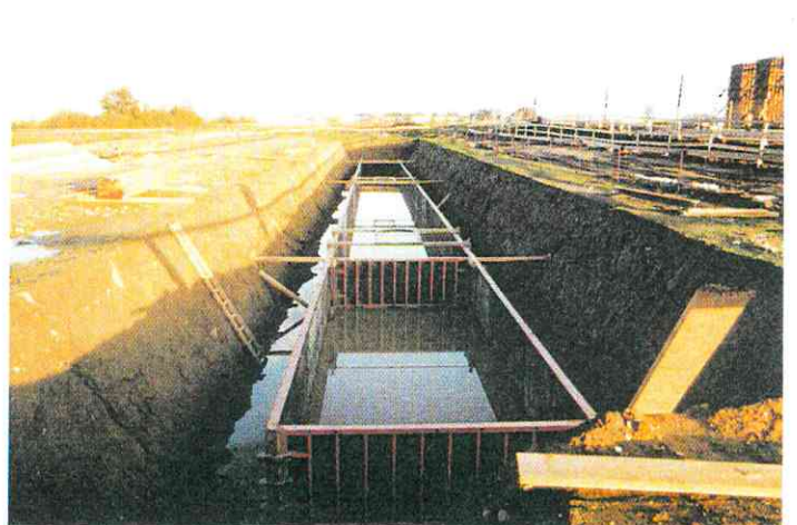
Foto 6: Gründungsarbeiten für die östlichen Rollbrücken des Flughafens
