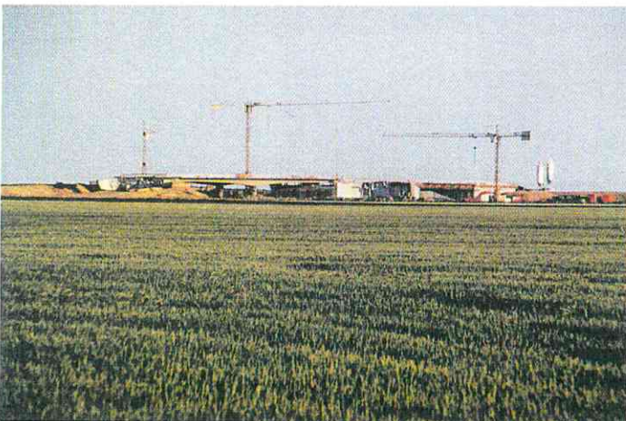
Foto 5: Brückenbauwerke an der Anschlußstelle Freiroda
