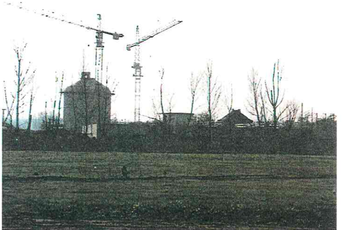
Foto 28: Bauliche Anlagen der Kläranlage Weißenfels
