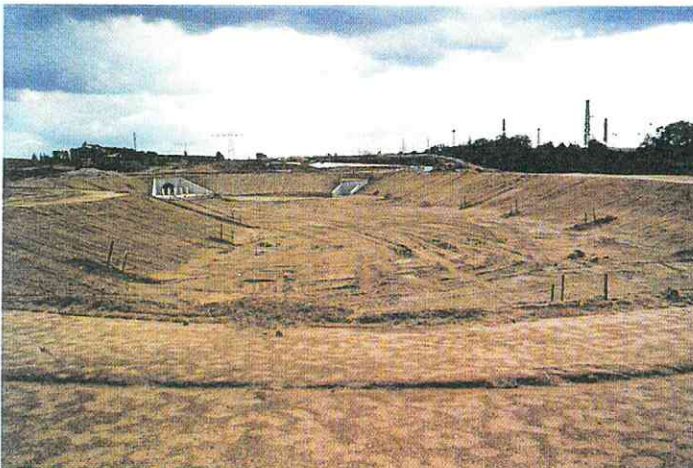
Foto 3: Regenwasserrückhalteanlage im GVZ (Quartier C) (Bauphase)
