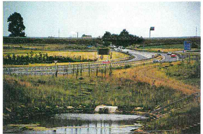
Foto 22: B91, Regenwasserrückhalteanlage und Autobahnanschlußstelle Weißenfels
