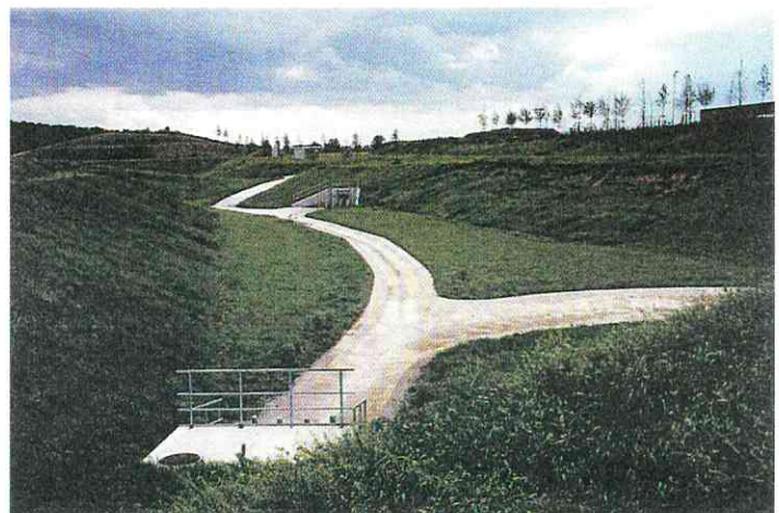
Foto 4: Regenwasserrückhalteanlage im GVZ (Quartier A) (Endzustand)
