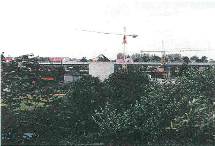
Foto 27: Saalebrücke und Faulturm der Kläranlage
