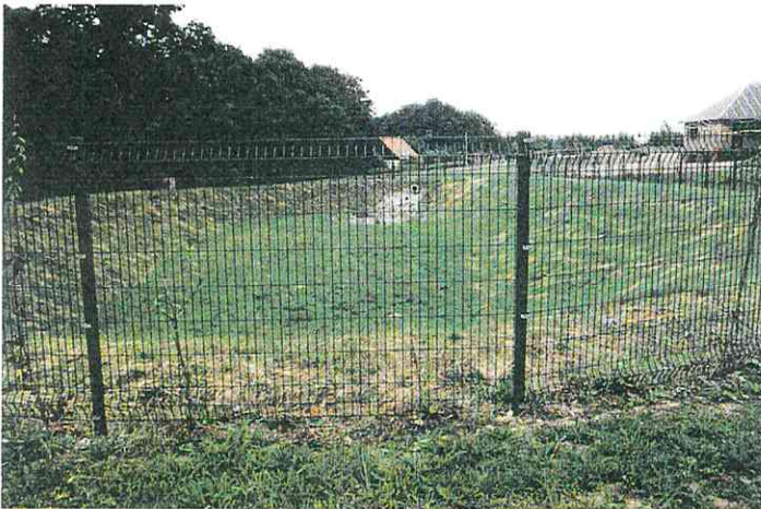
Foto 15: Regenwasserrückhalteanlage im Übergangsbereich zum Talhang des Saaletals (LEI06B)
