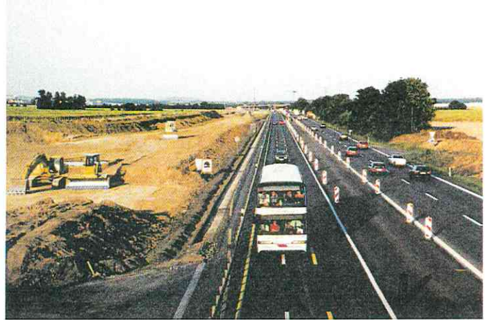
Foto 2: Verbreiterung der BAB A14 (Bauphase)
