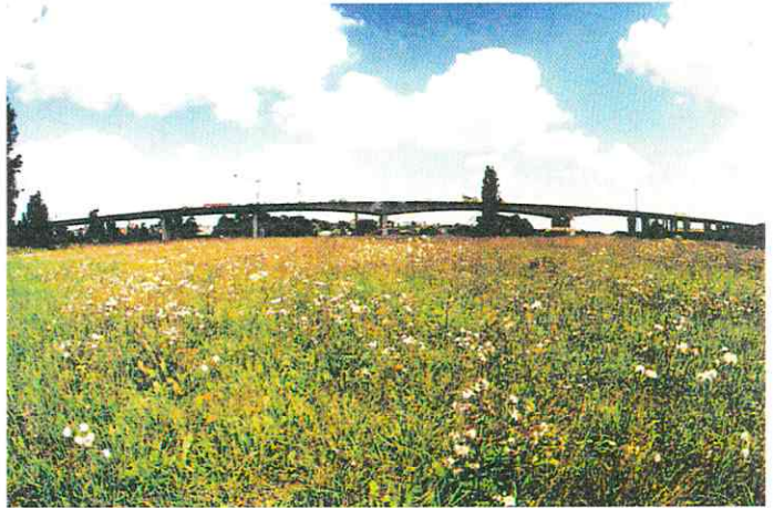
Foto 26: Saalebrücke beeinflusst die Durchgängigkeit der Saaleaue
