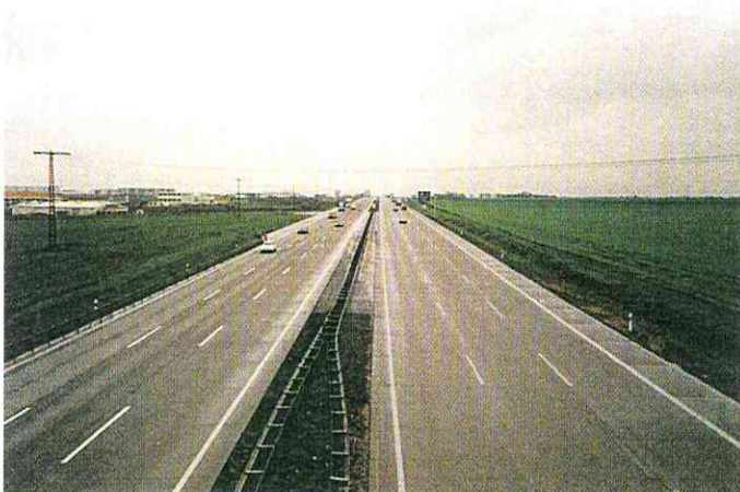
Foto 23: Sechsstreifig ausgebaute BAB A9 Gestaltungsmaßnahmen fehlen
