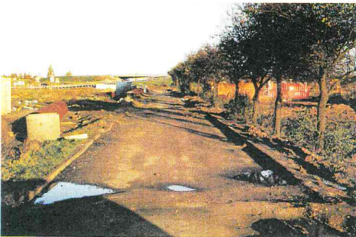
Foto 11: Flächen für Ersatzmaßnahmen (Entsiegelung, Extensivierung) während der Bauphase
