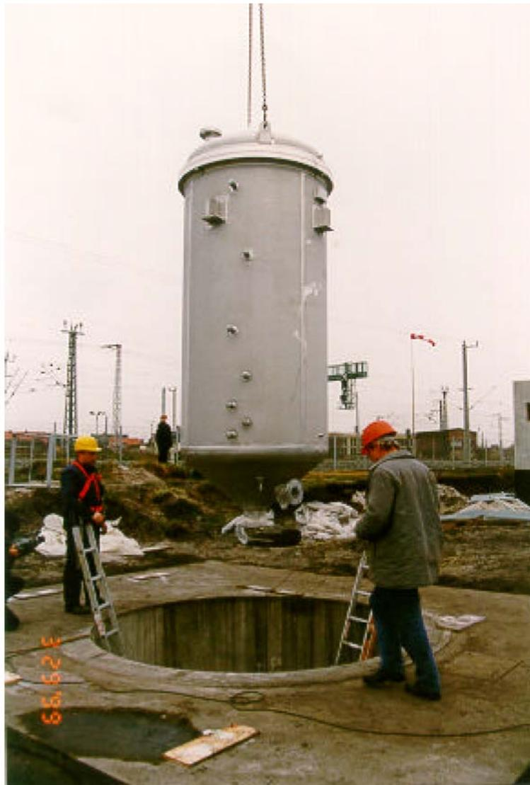
**Abb. 7:** Reaktoreinbau
