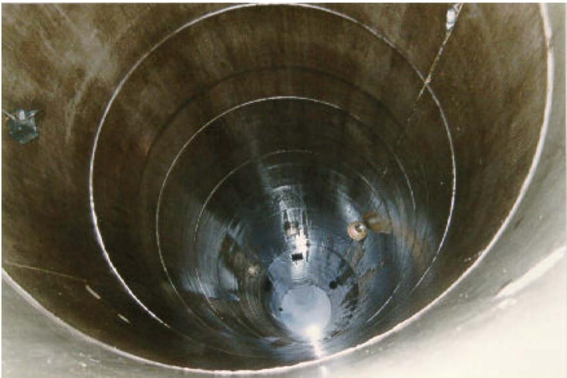
**Abb. 5:** Senkschacht mit horizontalen Brunnensträngen
