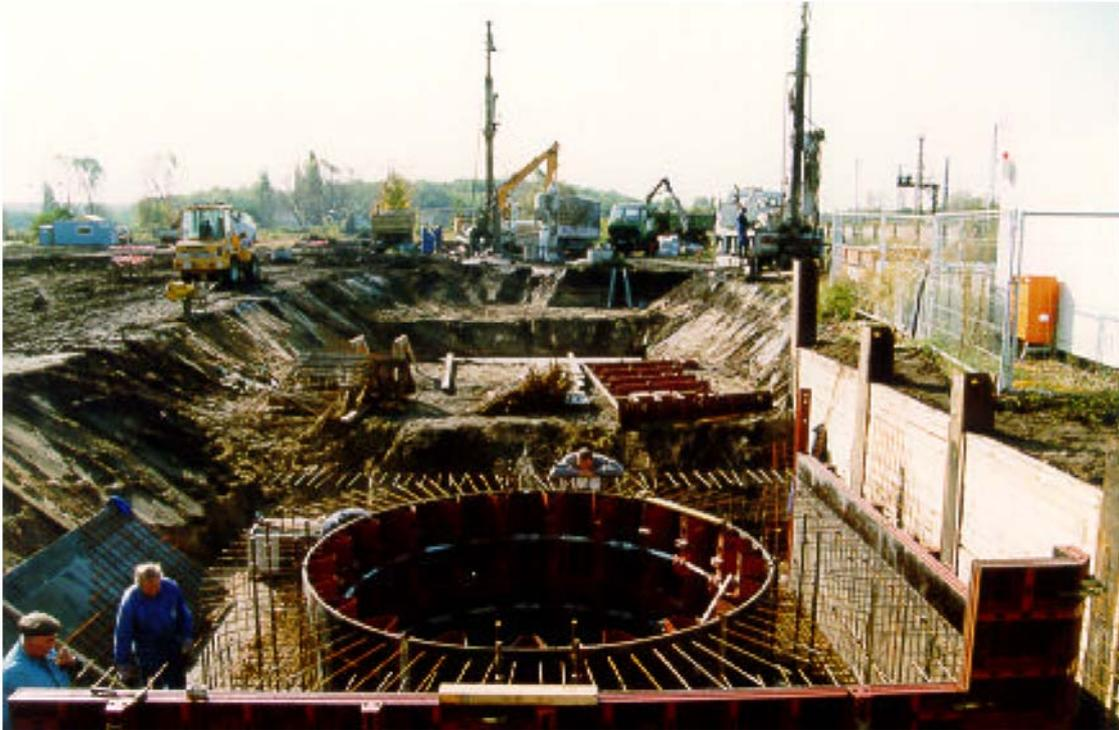
**Abb. 1:** Baugrundaushub und Herstellung der Bealstungsfundamente
