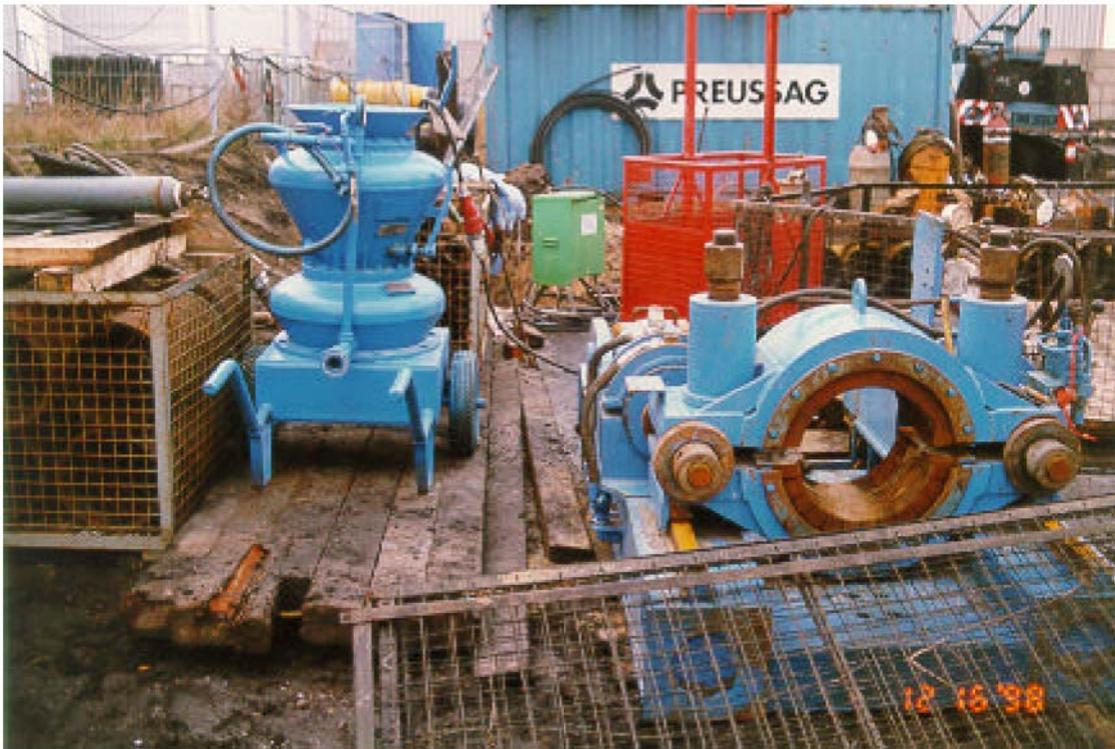
**Abb.: 4:** Baustelleneinrichtung für horizontale Wasserfassung mit Vortriebseinrichtung
