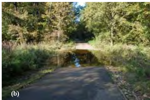
Abb. 4: (a) Absenkung eines Wegedammes in einer Flutrinne (Foto A. Eichhorn). (b) Durchströmung einer Flutrinnen mit abgesenktem Wegedamm nach abgelaufenem Hochwasser (Foto U. Patzak).
