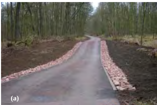
Abb. 4: (a) Absenkung eines Wegedammes in einer Flutrinne (Foto A. Eichhorn). (b) Durchströmung einer Flutrinnen mit abgesenktem Wegedamm nach abgelaufenem Hochwasser (Foto U. Patzak).
