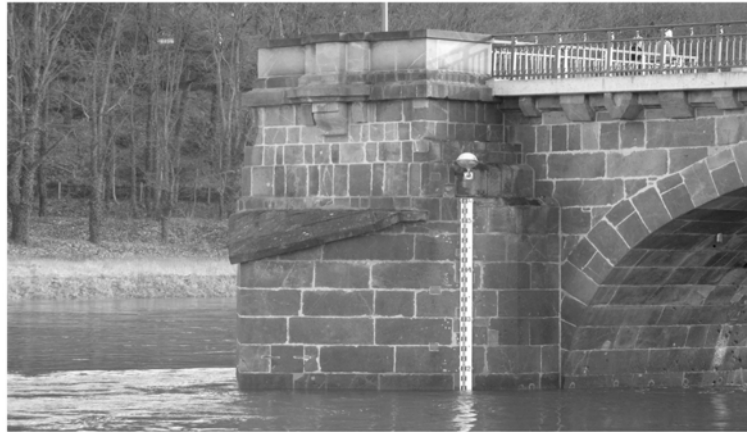
Abbildung 17: Pegel an der Pöppelmannbrücke (Quelle: eigenes Foto)
