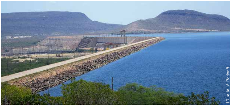
Die Staumauer des Itaparica Stausees mit sechs Turbinen mit je 250 Megawatt Nennleistung.
