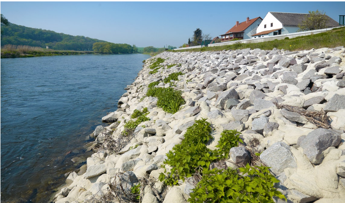
Uferbefestigungen an der Mulde in Sachsen. Zwar sind die chemischen Belastungen von Flüssen und Seen in Deutschland erheblich zurückgegangen, trotzdem bleibt der ökologische Zustand der meisten Gewässer unbefriedigend. Häufig sind wasserbauliche Maßnahmen wie Ausbau für die Schifffahrt oder Hochwasserschutz dafür verantwortlich.
