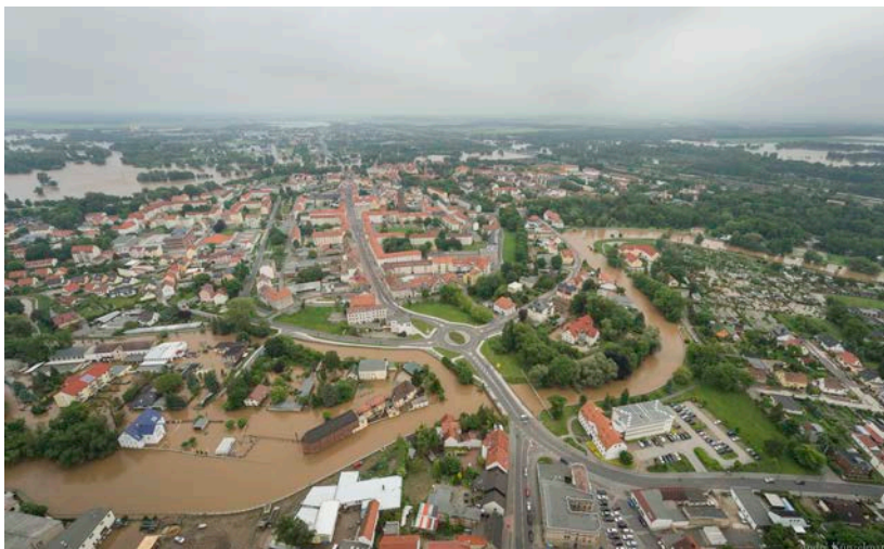
Abbildung 6.1: Eilenburg während des Hochwassers 2013
