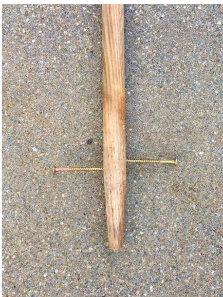
**Abb. 4:** Falls Rundstäbe als Stangen genommen werden, kann man die Stange mit der Kopfdose mit 2 Schrauben (hier: 60 mm lang) gegen Verdrehen im Boden sichern
