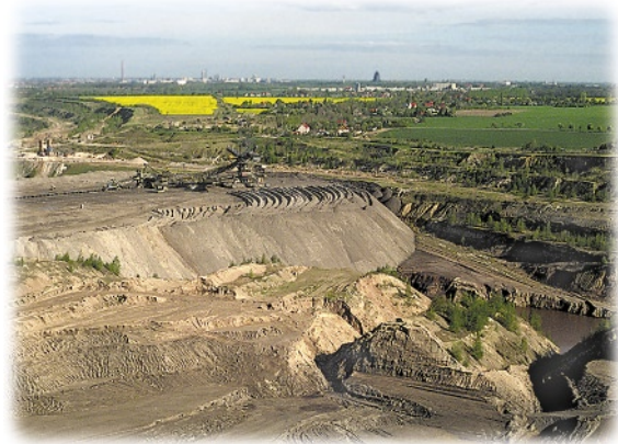
Bild 9: Schüttung des Autobahndammes für die A38 quer durch den Tagebau (Foto: Sigrun Kabisch, UFZ)
