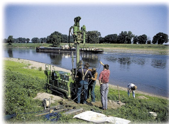
Bild 1: Einrichtung ufernaher Messstellen für Infiltrationsuntersuchungen im Profil Torgau-Ost I. (Foto: Rolf Trettin, UFZ)
