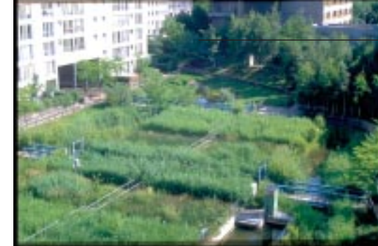
Pflanzenkläranlage für kommunales Abwasser
