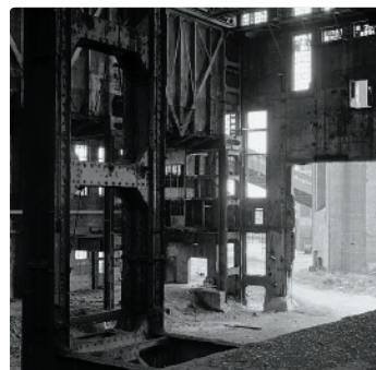
Chemiekombinat Bitterfeld, Altwerk 1991
