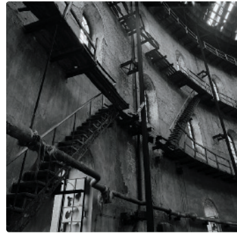
Gasometer im Heizkraftwerk Leipzig 1993
