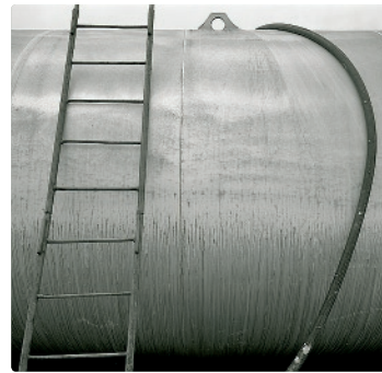
Fernwärmerohr / Industriehafen, Dortmund, 1999
