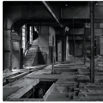
Chemiekombinat Bitterfeld, Altwerk 1991
