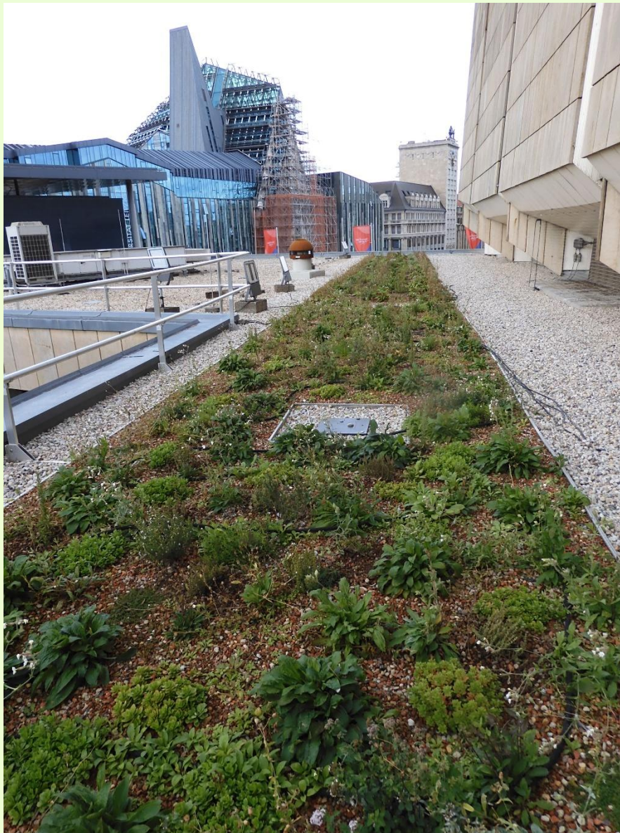
Abbildung 4: Gründachsegment (extensiv [vorn] und einfach intensiv begrünt) auf der Westseite (Foto aufgenommen am 24. September 2025).
