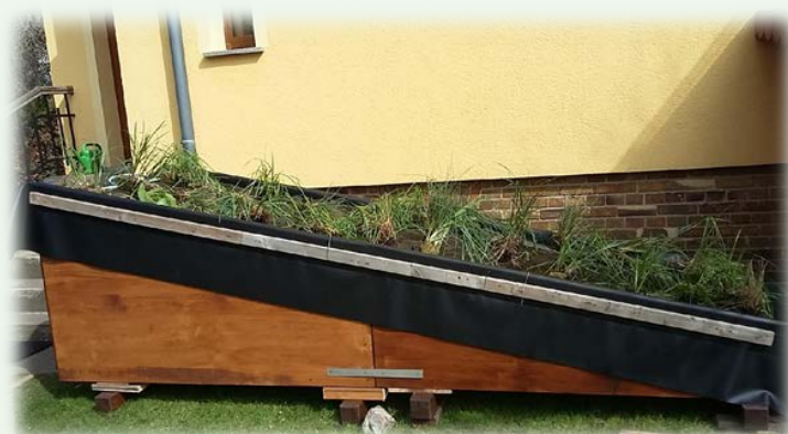
Sumpfpflanzendach zur Grauwasserbehandlung Autorin: L. Moeller (UBZ)
