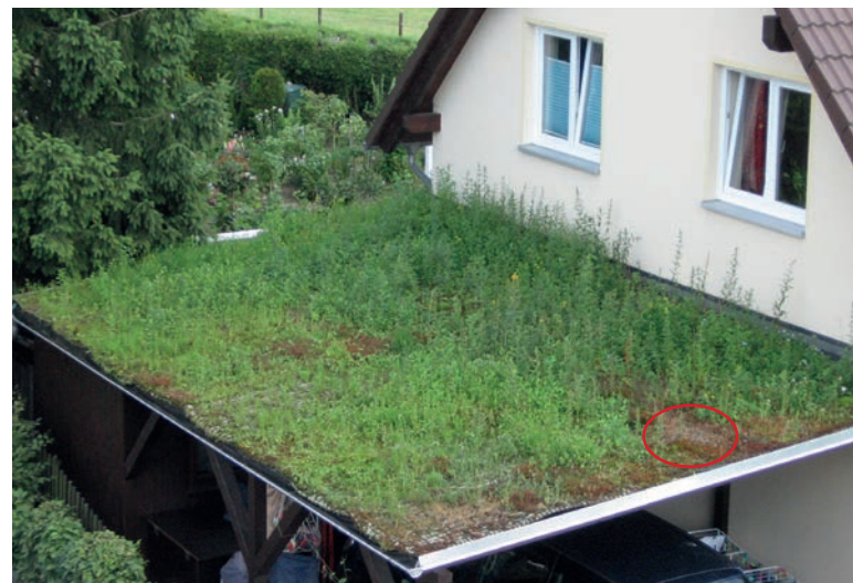
Abb. 8: Trockenschäden durch Bewässerungsfehler (oben) Juli 2010, (unten) Juli 2014 (Fotos: Mählmann).
