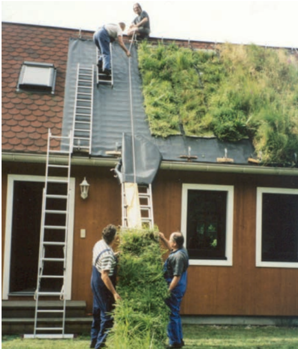
Abb. 1: Montage einer Dachvegetation mit textilen Vegetationsträgern am „Öko-Versuchshaus“ in Freital-Hainsberg bei Dresden (Fotos: Archiv STFI).
