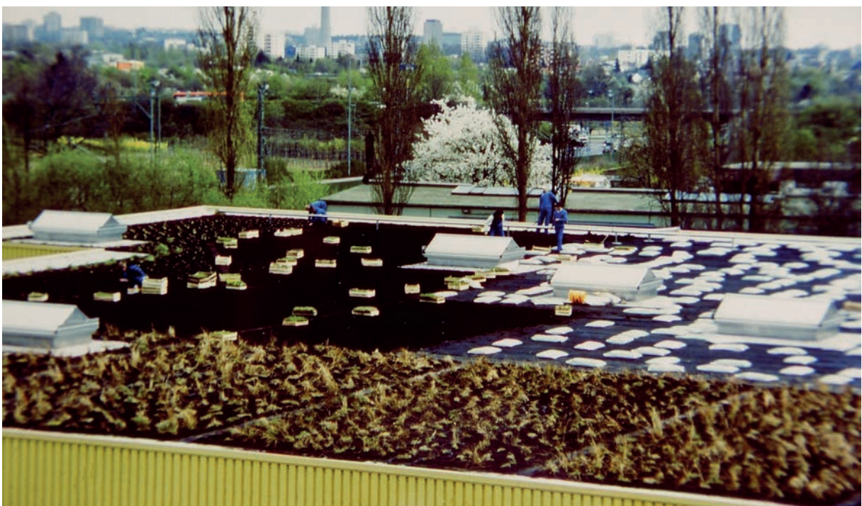
Abb. 4: Aufbau und Bepflanzung des Sumpfpflanzendaches. (Foto: Possmann).
