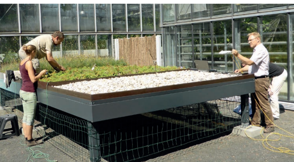
Abb. 5: Test unterschiedlicher Sensoren und Messtechnik an den verschiedenen Dächern (Foto: I. Grommlich).
