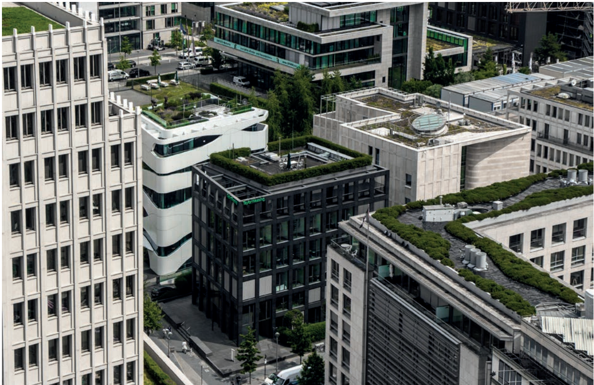
Abb. 2: Dachbegrünungen sind Stand der Technik zur Begrünung von Innenstädten (Foto: Günther).
