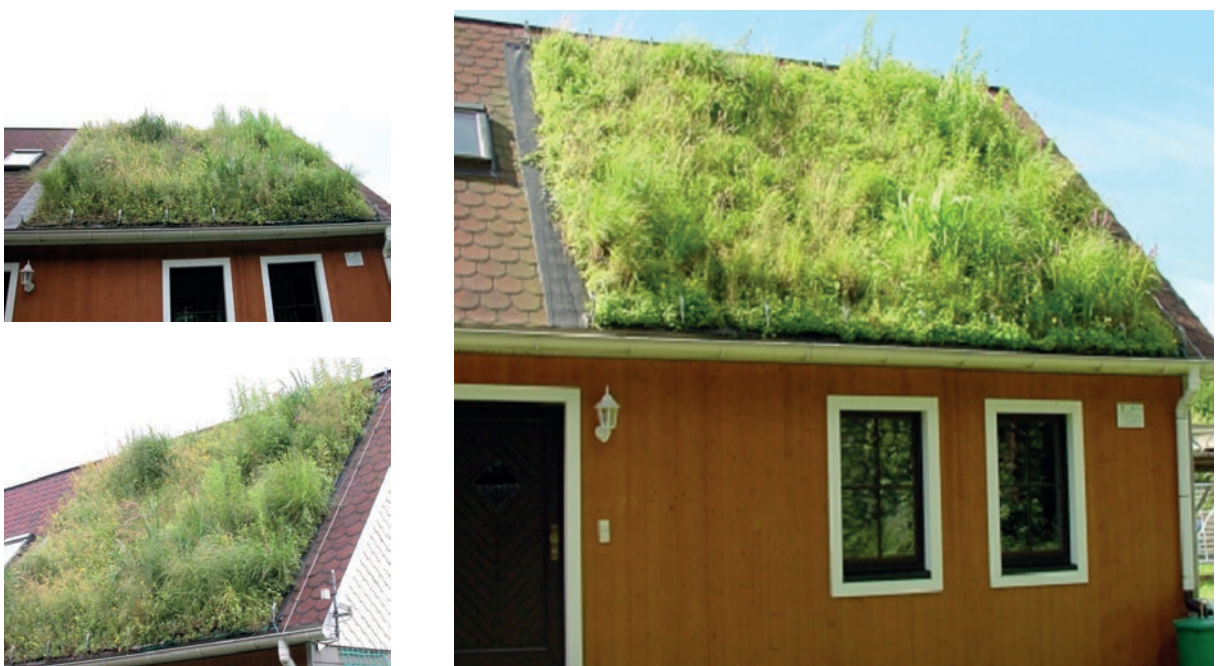
Abb. 3: Schrägdachbepflanzung mit textilen Vegetationsträgern am „Öko-Versuchshaus“ in Hainsberg bei Dresden (Fotos: Archiv STFI).
