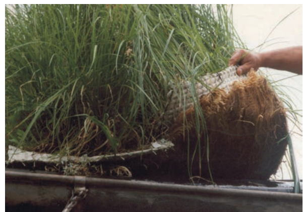
Abb. 2: Durchwurzelter textiler Vegetationsträger zur erdelosen Dachbegrünung (Foto: Archiv STFI).
