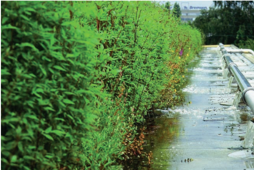
Abb. 3: Gleichmäßige Verteilung des zu kühlenden Wassers am Zulauf des Sumpfpflanzendaches. (Foto: Possmann).
