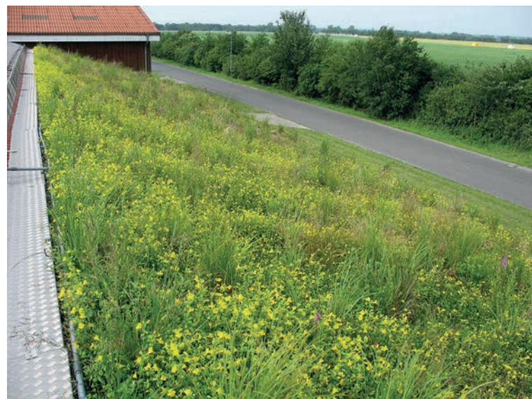
Abb. 4: Sumpfpflanzendach auf einer Dachhälfte des Stallgebäudes (Ostseite) im Juni 2006 (Foto: H. Georg).
