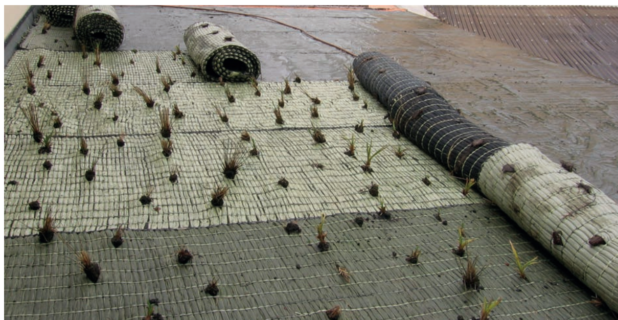
Abb. 9: Austausch der Wurzelschutzfolie (beschichtete Gewebeeplane gegen PVC-Teichfolie) im April 2009 (Foto: Mähmann).
