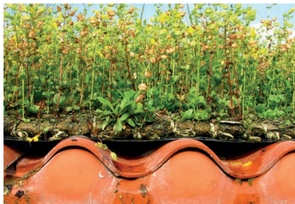
Abb. 2: Traufseite mit Faserzementdach, Wurzelschutzfolie und Repotex®-Pflanzenmatte (Foto: H. Georg).
