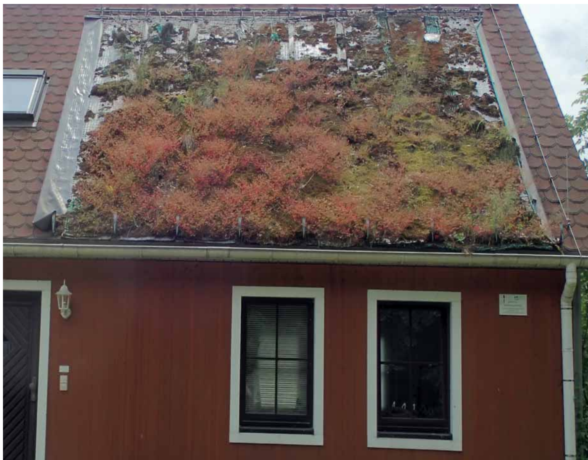
Abb. 7: Erste Alterungserscheinungen an den textilen Vegetationsträgern nach 25 Jahren Standzeit, (2019) (Fotos: Archiv STFI).
