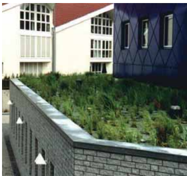
Abb. 2: „Pflanzenklimaanlage“ mittels Flachdach mit Anstaubbewässerung am Beispiel des „blauen Hauses“ in Mülheim an der Ruhr (Fotos: Ulrich Zens).
