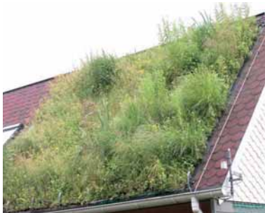
Abb. 3: Schrägdachbepflanzung mit textilen Vegetationsträgern am „Öko-Versuchshaus“ in Hainsberg bei Dresden (Fotos: Archiv STFI).
