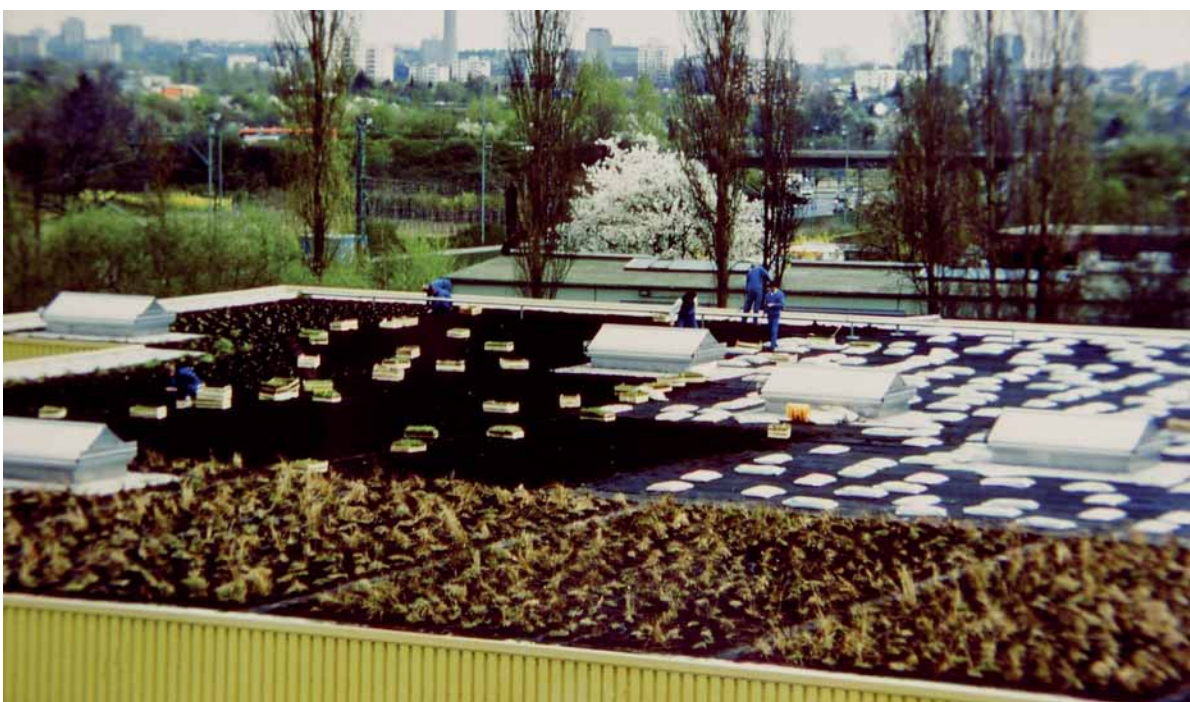
Abb. 4: Aufbau und Bepflanzung des Sumpfpflanzendaches. (Foto: Possmann).
