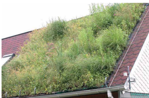
Abb. 4: Schrägdachbepflanzung mit textilen Vegetationsträgern am „Öko-Versuchshaus“ in Hainsberg bei Dresden, 2001 (Fotos: Archiv STFI).
