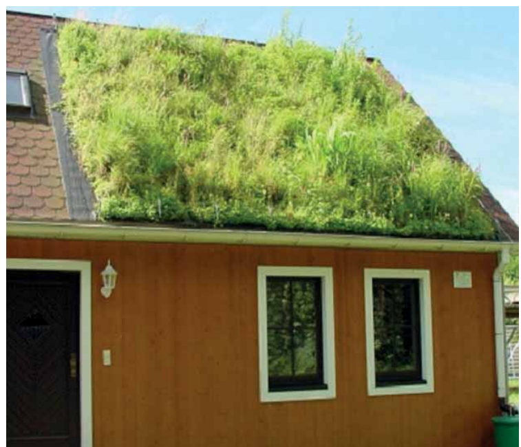
Abb. 3: Schrägdachbepflanzung mit textilen Vegetationsträgern am „Öko-Versuchshaus“ in Hainsberg bei Dresden (Fotos: Archiv STFI).
