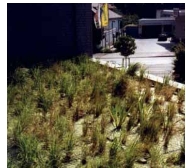
Abb. 2: „Pflanzenklimaanlage“ mittels Flachdach mit Anstaubbewässerung am Beispiel des „blauen Hauses“ in Mülheim an der Ruhr (Fotos: Ulrich Zens).
