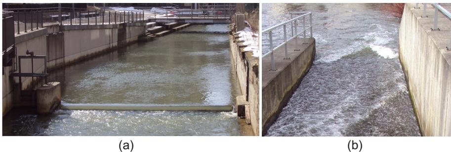
Abbildung 3.15: Strömung an Wehren: (a) Thomaswehr in Leipzig; (b) Schussrinne am Lindenauer Mühlwehr.
