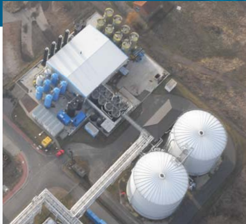
Grundwasserreinigungs- anlage in Bitterfeld
