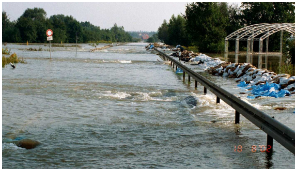
Abb. 3-15 Überflutung der Bundesstraße B100 aus Richtung des Goitzschesees
