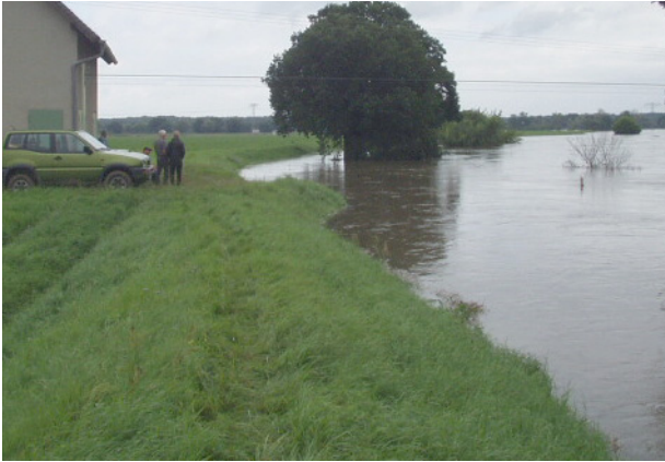
Abb. 3-34 Pegel Priorau 2002 mit einer damaligen Deichhöhe von 70,93 mNN. Die hier gemessenen Wasserstände bilden die untere Randbedingung des Modells.
