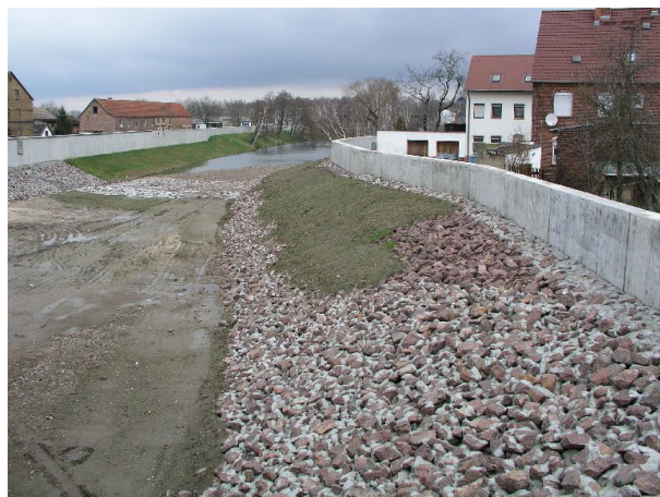
Abb. 3-44 Neu errichtete Deiche am Spittelwasser in Jeßnitz
