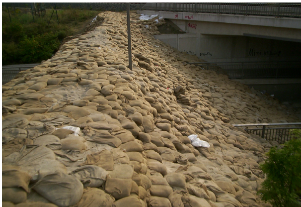
Abb. 3-37 Kritische Stelle K2: Dessauer Straße in Bitterfeld. 2002 wurde eine Sandsackbarriere errichtet (Aufnahme LHW, M. Böhme)
