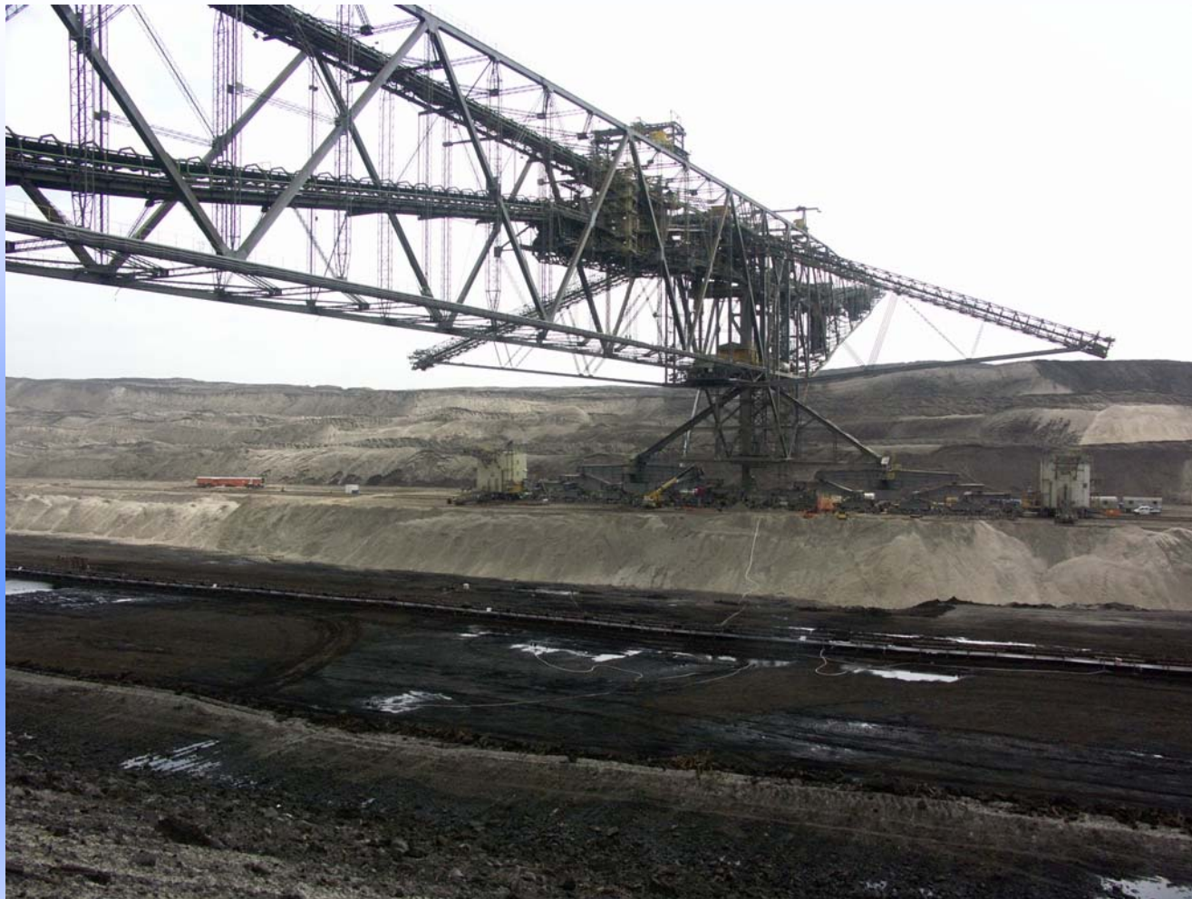
Förderbrücke F60, Tagebau Nochten
