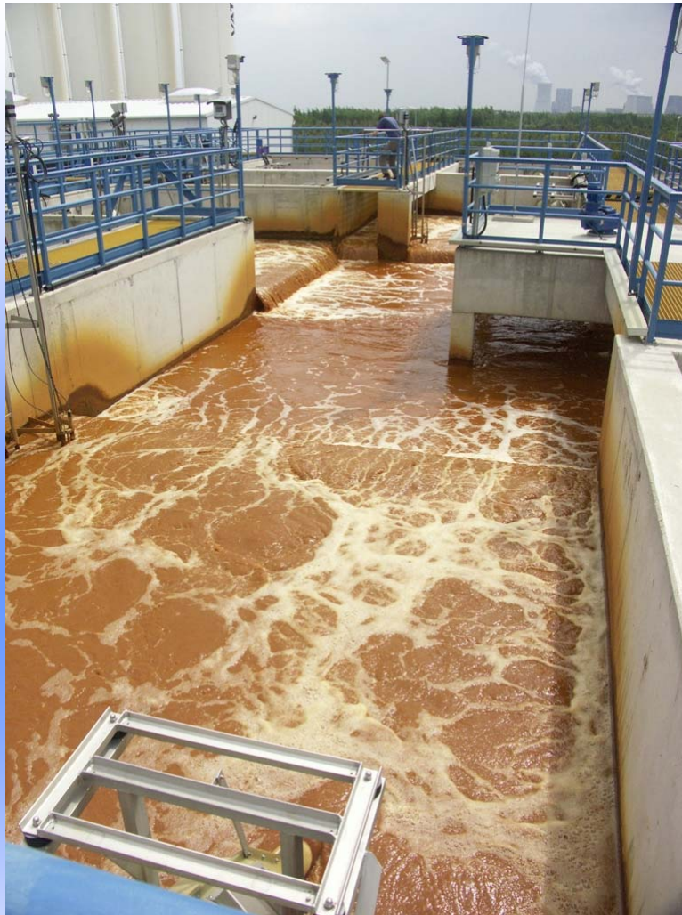
Grubenwasserreinigungsanlage Tzschelln, Tagebau Nochten
