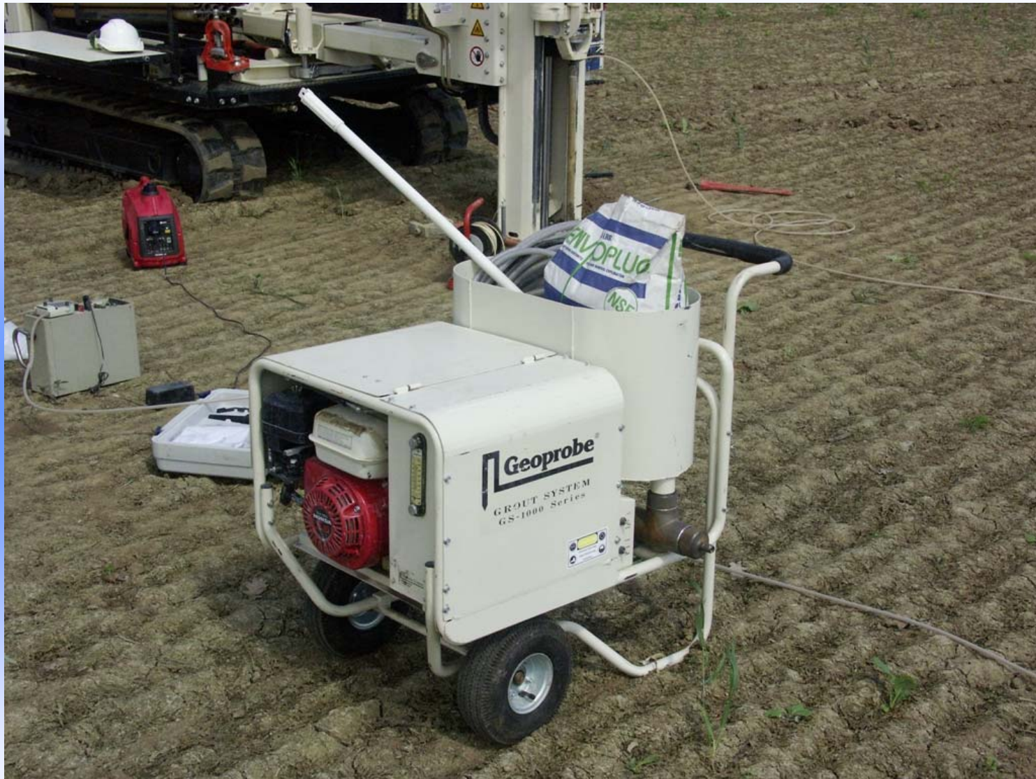
Verpressung der Bohrung mit Suspension
