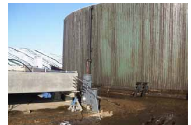
Bild 2b: Übergelaufener Fermenter nach Aufblähen des Fermenterinhalt („Hefeteigeffekt“)
