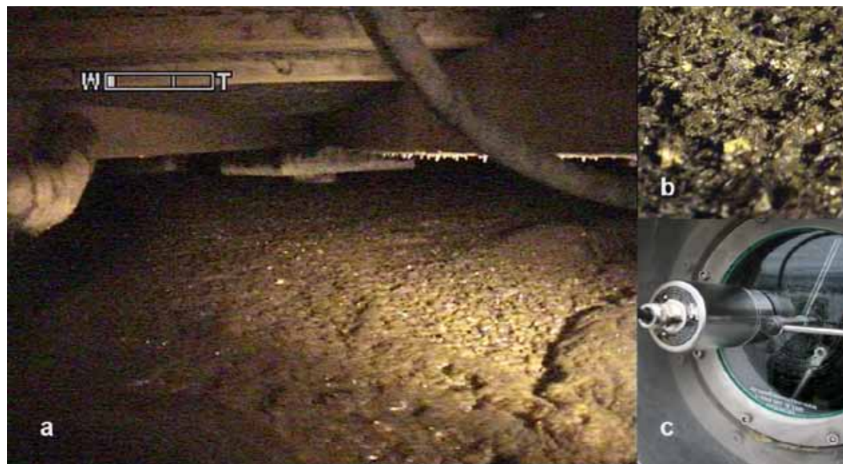
Abbildung 5: Überwachung eines Fermenters mit einer Ex-Zonen-Videokamera (c) mit Weitwinkel- (a) und Zoom-Funktion (b), (WIESE et al., 2008)
