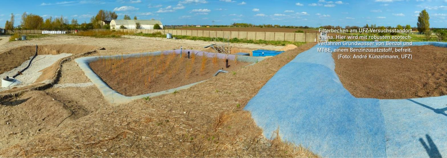
Filterbecken am UFZ-Versuchsstandort Leuna. Hier wird mit robusten ecotech-Verfahren Grundwasser von Benzol und MTBE, einem Benzinzusatzstoff, befreit. (Foto: André Künzelmann, UFZ)
