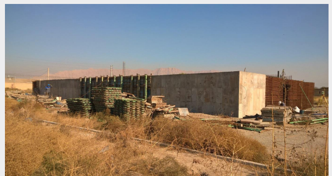
Abbildung 8: Bau der Testanlage für dezentrales Abwassermanagement in Teheran, Dezember 2017 (Foto: Dr. Gabi Stich, BDZ e.V.)
