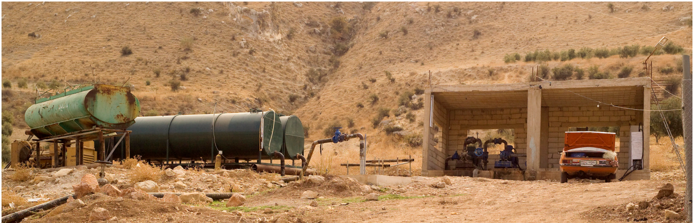
Abbildung 10: Trinkwassertanks im Wadi Rum, Jordanien
